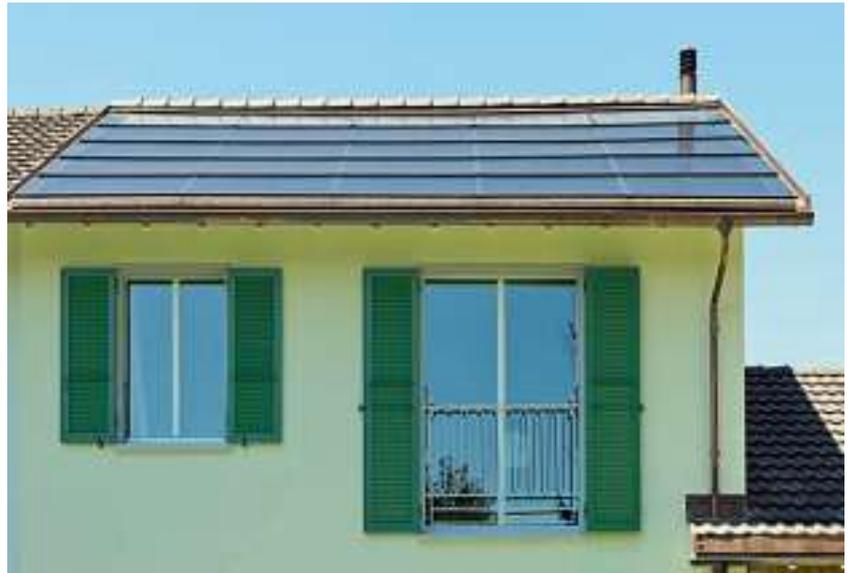
ter in den Räumen zu halten; daher wurden 200 mm Fassadendämmung aufgebracht. Die neuen Fenster liegen optimal überdämmt in der Fassade, dabei fielen die Laibungen nicht sehr tief aus und lassen grosszügig Sonnenlicht einfallen. Auf die Dämmplatten wurde wie im Bestand Putz aufgebracht. Details wie die für die Entstehungszeit typischen, feingliedrigen Fenstergitter im Erdgeschoss wurden neu interpretiert wieder eingesetzt.
