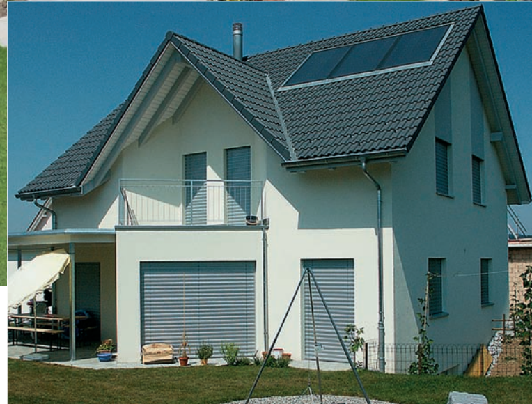
Mit rund 5 m 2 Kollektorfläche 70% des Warmwasserbedarfs mit der Sonne abdecken. Quelle: Conergy
