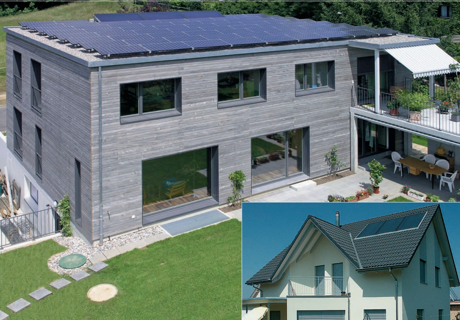
Einfamilienhaus in Riehen BS mit Solarstrom- und Solarwärmanlage. Solarpreis 2008. Copyright Solaragentur.
