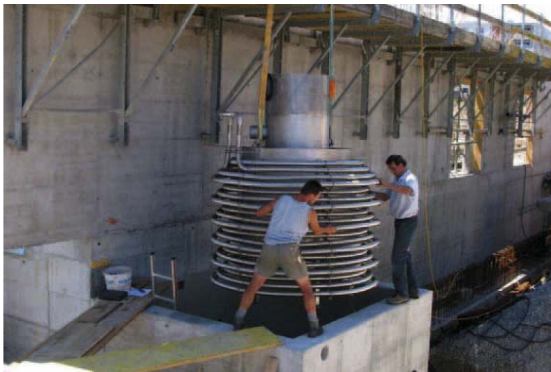
Einbau des FEKA-Modul
