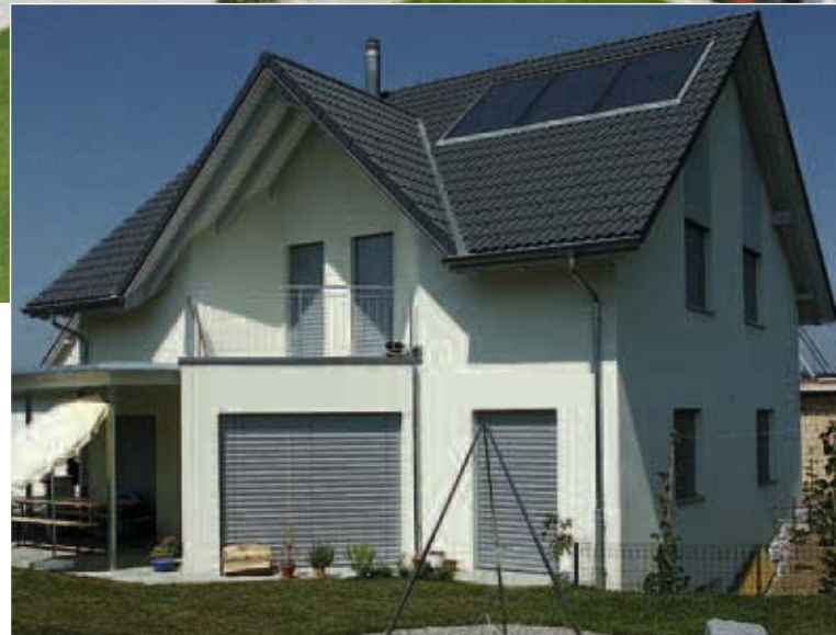
Mit rund 5 m 2 Kollektorfläche 70% des Warmwasserbedarfs mit der Sonne abdecken. Quelle: Conergy
