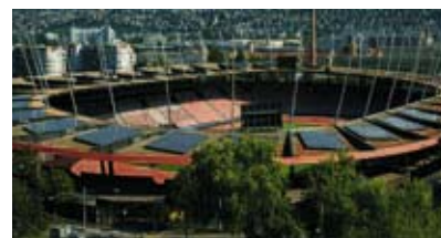
Erneuerbare Energien: Solaranlage auf dem Dach des Stadions Letzigrund, Zürich
